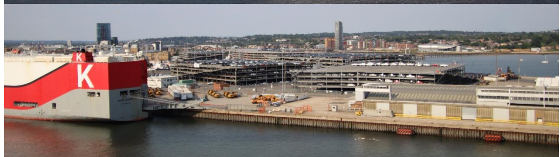
狭い港を自動車運搬船の荷役機能をもたせるために建設されている幾層もの立体駐車場。
